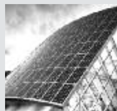
PV-Module mit Antireflex-Glas
